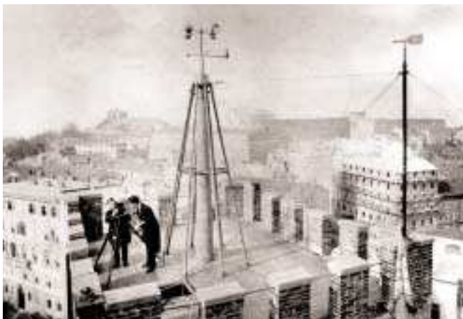
Figura 1. La torretta dell'Osservatorio Marittimo di Trieste: anemometro a coppe Beckley e anemometro a pressione Dines (tubo di Pitot, a destra). Foto dall'archivio dell'Osservatorio Astronomico di Trieste, 1910 circa).
